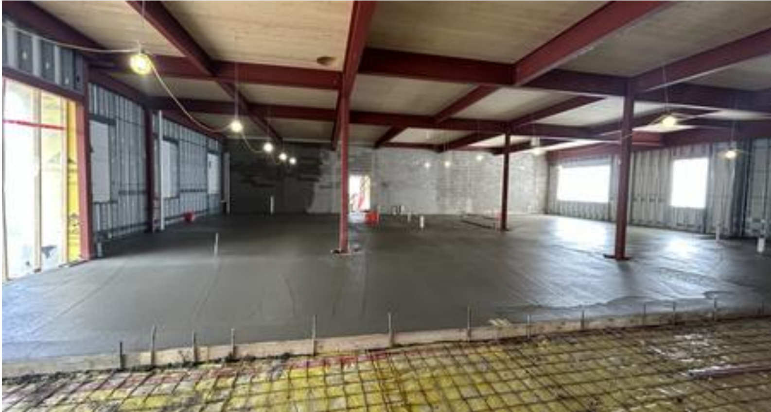
Concrete Pour in Classrooms
