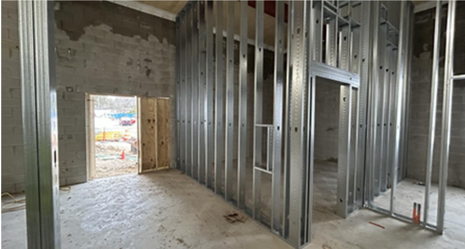
Concrete Pour & Framing in Kitchen
