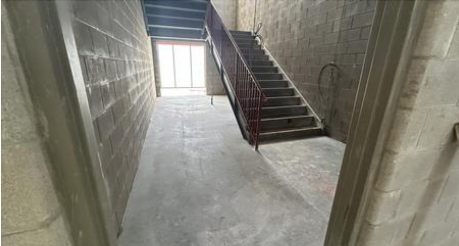
Concrete Floor Slab Pour in Stair Tower
